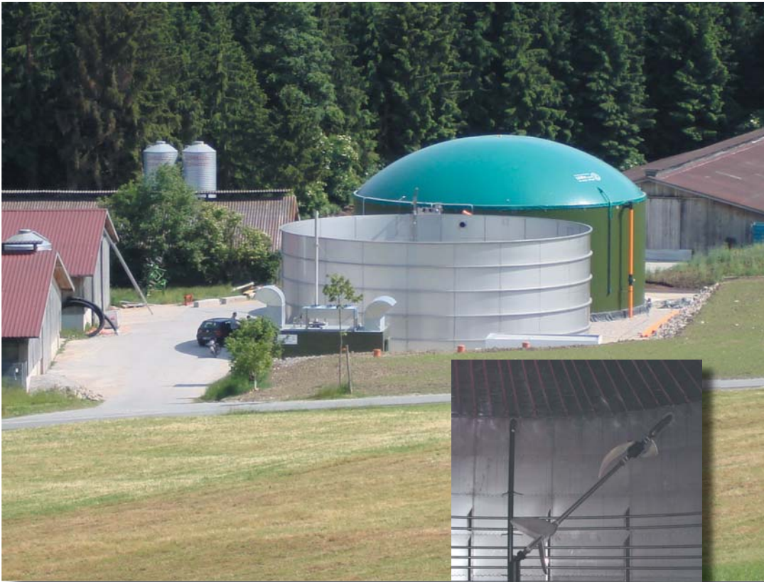
Gut heizen und gut rühren für gute Erträge: Lüthe Edelstahl-Rohrwandheizung und Lüthe-Power-Mix-Rührwerk
