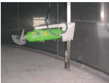
Bewährte Tauchmotorrührwerke für Biogasfermenter in spezieller Druckkapselung für höchste An- sprüche und Langlebigkeit.
