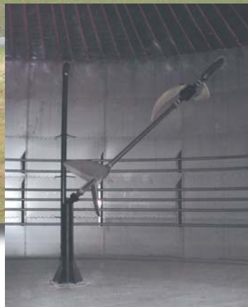
Gut heizen und gut rühren für gute Erträge: Lüthe Edelstahl-Rohrwandheizung und Lüthe-Power-Mix-Rührwerk
